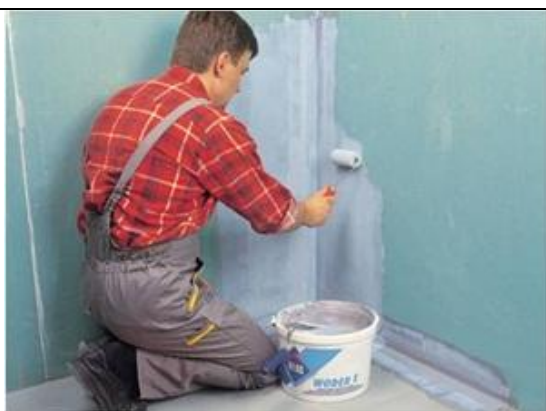
14 pav. Sandarinimo masės paskirstymas ant drėgnų ir šlapių plotų
