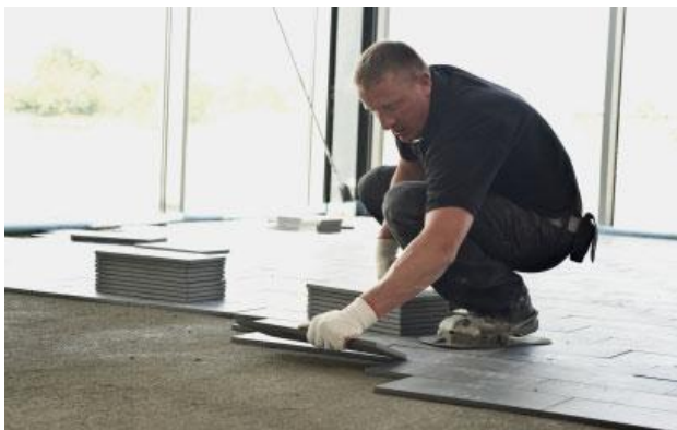
13 pav. Plytelių klijavimas
