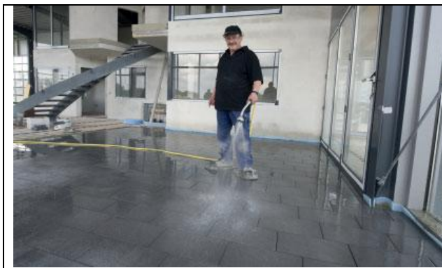
15 pav. Plytelių dangos drėkinimas
