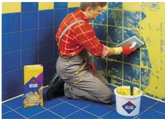
29 pav. Siūlių užpildymas glaistu
