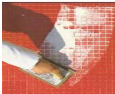
17 pav. Siūlių užpildymas
