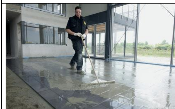
17 pav. Siūlių užpildymas
