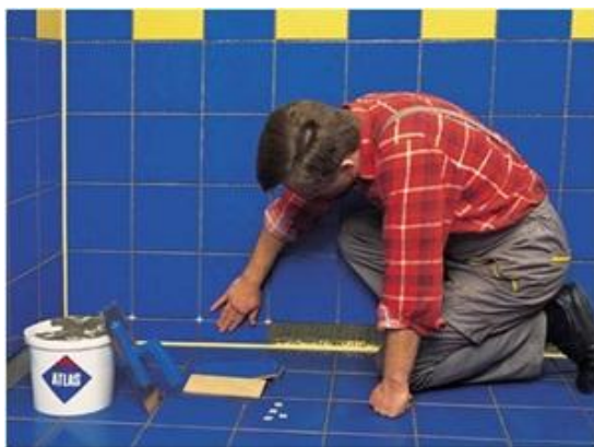
27 pav. Pirmosios plytelių eilės klijavimas
