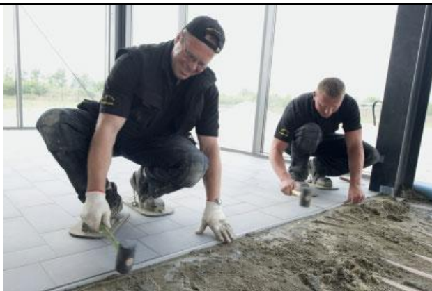
14 pav. Deformacinių siūlių formavimas
