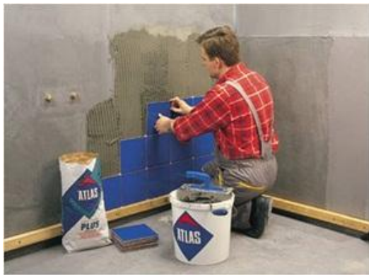
19 pav. Pirmųjų plytelių eilių klijavimas
