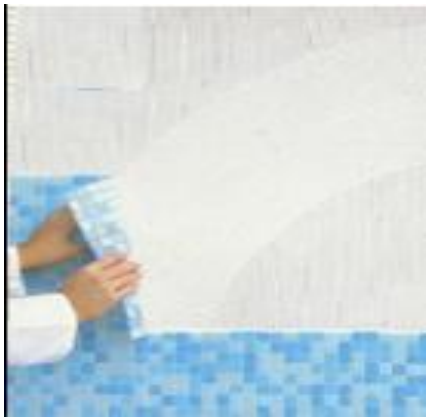
8 pav. Mozaikinių plytelių tvirtinimas
