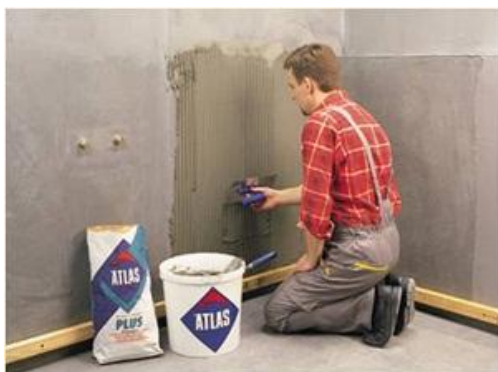
18 pav. Klijų užtepimas ant sienos
