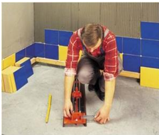
7 pav. Plytelių pjaustymas
