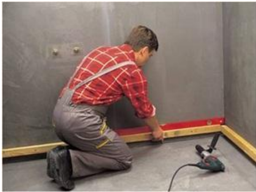
17 pav. Pirmosios plytelių eilės nuymėjimas
