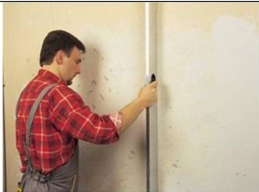
8 pav. Sienos lygumo patikrinimas
