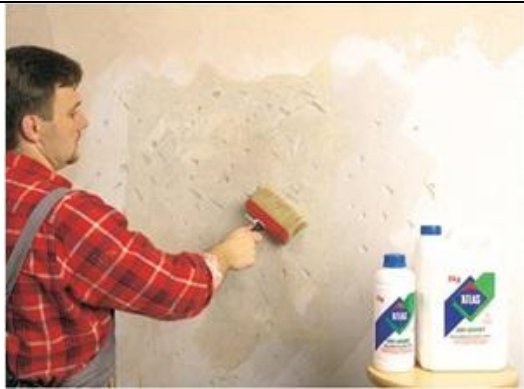
7 pav. Sienos gruntavimas
