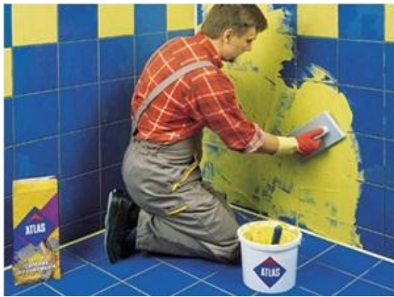
28 pav. Siūlių glaisto paskirstymas
