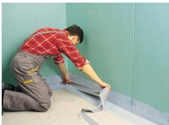
12 pav. Sandarinimo juostos tvirtinimas
