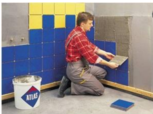
21 pav. Klijų pasiskirstymo po plytele
