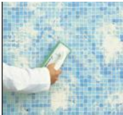
9 pav. Siūlių užpildymas
