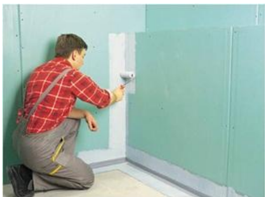
11 pav. Kampų ir siūlių sandarinimas hidroizoliacine mase
