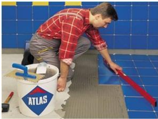
6 pav. Plytelių horizontalumo patikrinimas
