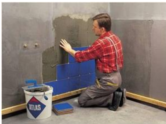
20 pav. Klijų lipnumo patikrinimas
