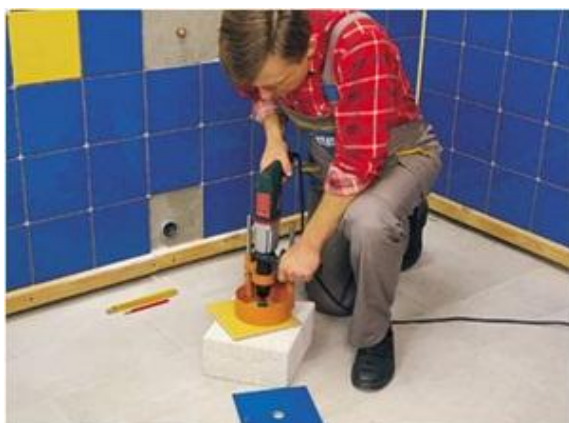
24 pav. Kiaurymių plytelėse grėžimas
