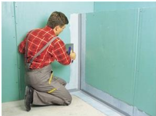
13 pav. Antrojo sandarinimo masės sluoksnio užtepimas
