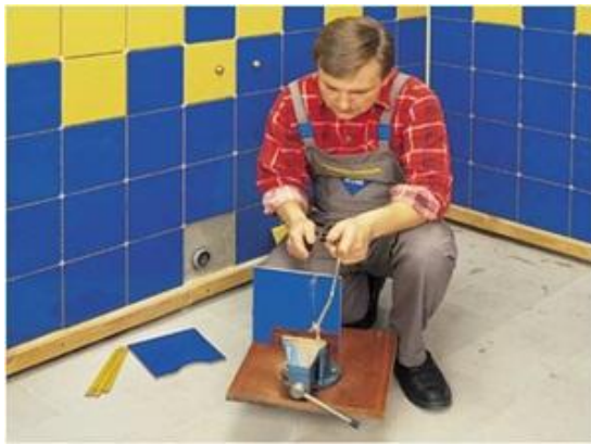
25 pav. Angų plytelės krašte pjovimas
