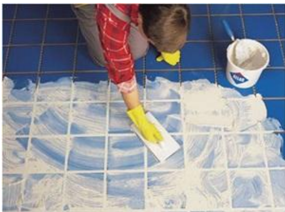
9 pav. Plytelių glaisto paskirstymas
