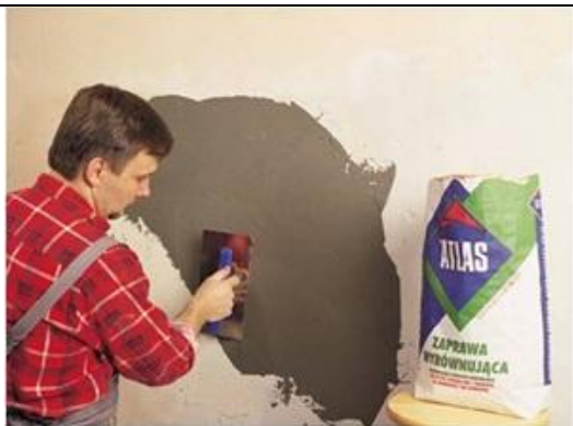
10 pav. Didelių nelygių plotų lyginimas
