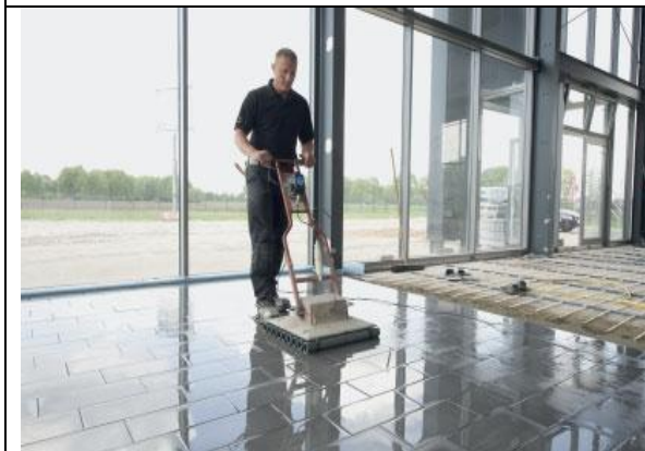
16 pav. Plytelių dangos lyginimas vibrotankintuvu
