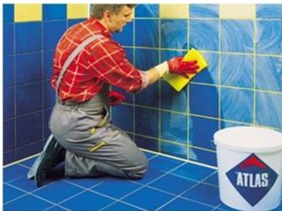
31 pav. Galutinis plytelių valymas
