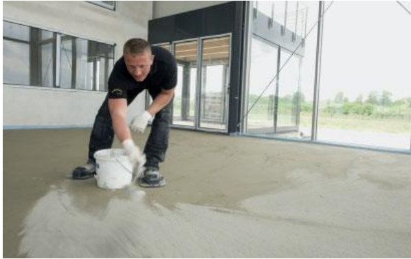
12 pav. Sauso cemento barstymas
