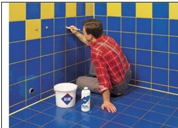
33 pav. Siūlių impregnavimas
