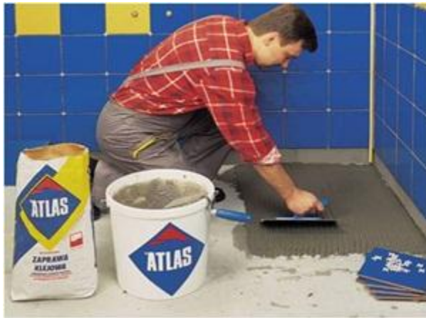
4 pav. Klijų skiedinio paskirstymas ant pagrindo
