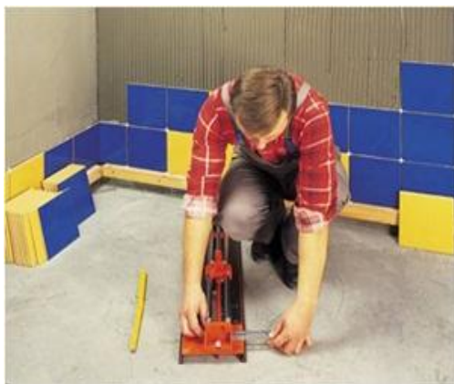
23 pav. Plytelių pjaustymas
