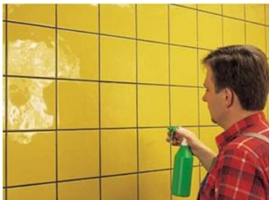
32 pav. Naujų siūlių drėkinimas
