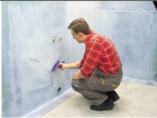
16 pav. Antrojo sluoksnio užtepimas drėgnose patalpose
