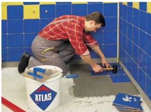
5 pav. Plytelių klijavimas
